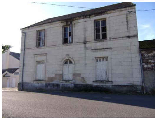
façade côté rue
